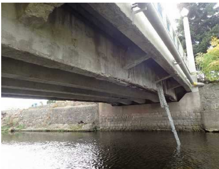
Podhled nosné konstrukce podél pravého boku mostu, směrem k opěře O2.
