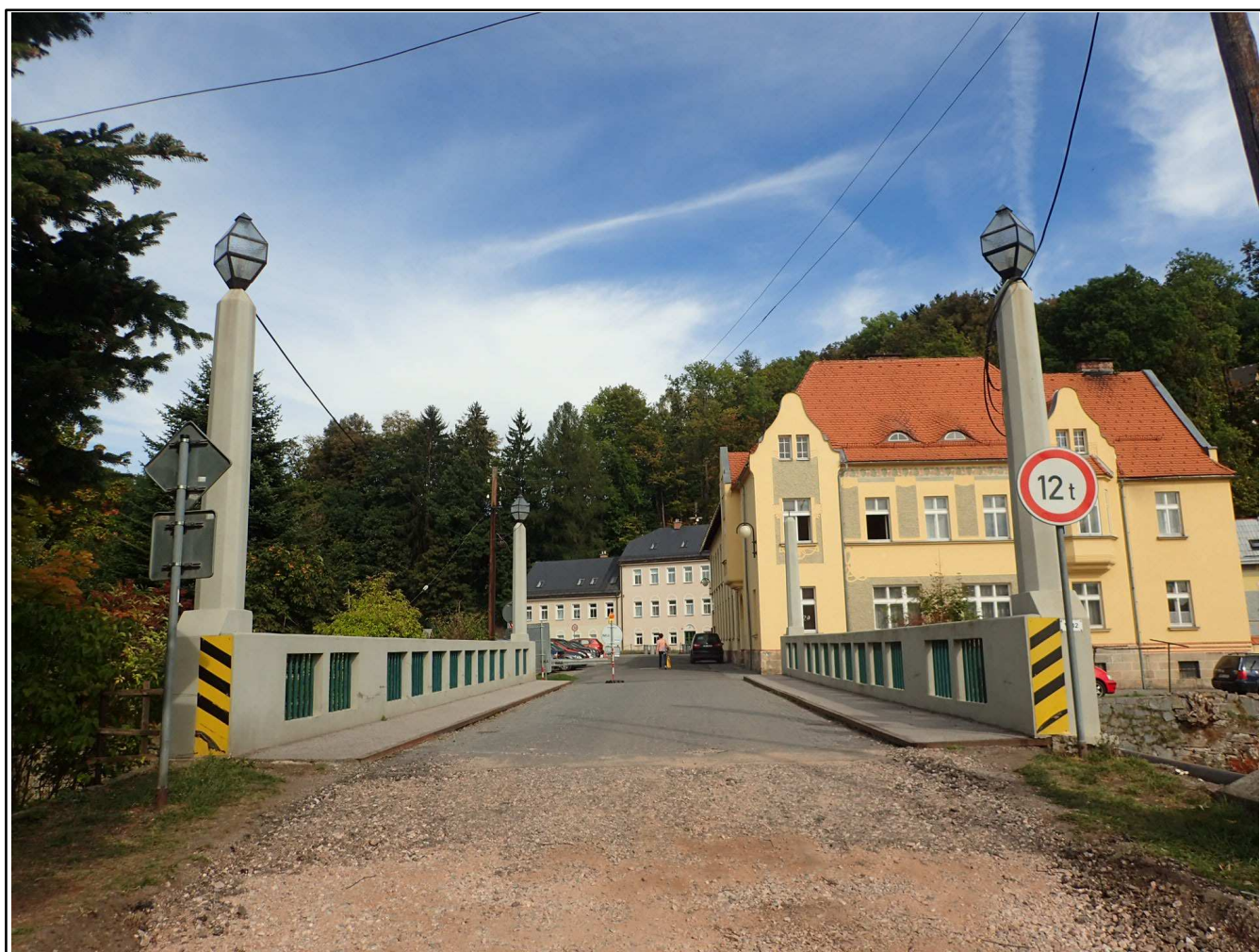
Most V-32 přes Labe, místní název u "Rozkročáku"
