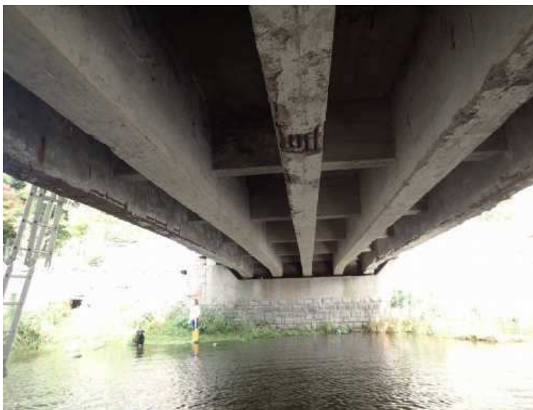
Podhled vnitřní části nosné konstrukce od opěry O2 směrem k O1.
