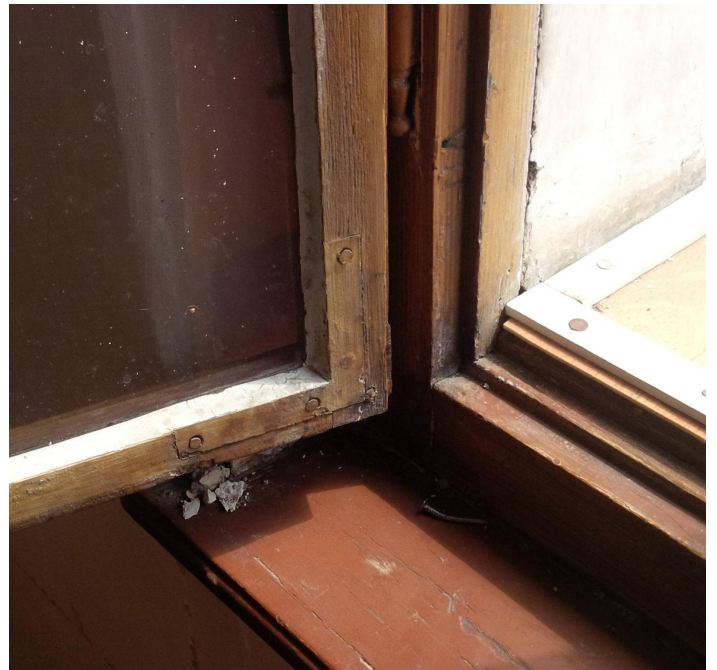
spojení křídla pomocí úhelníků
