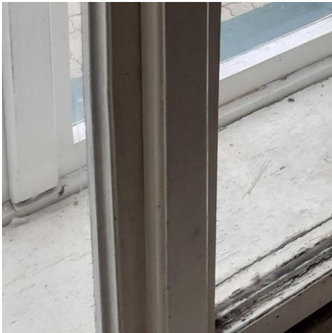
detail profilování okna
