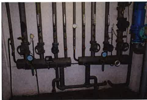
Plynová kotelna – rozdělovač a sběrač
