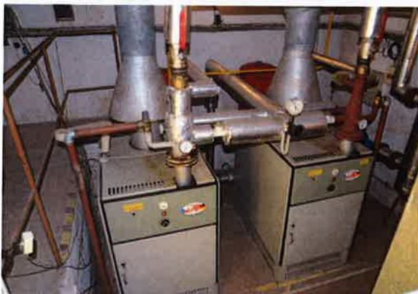
Plynová kotelna – kotle Höterm
