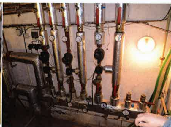
Plynová kotelna – rozdělovač a sběrač
