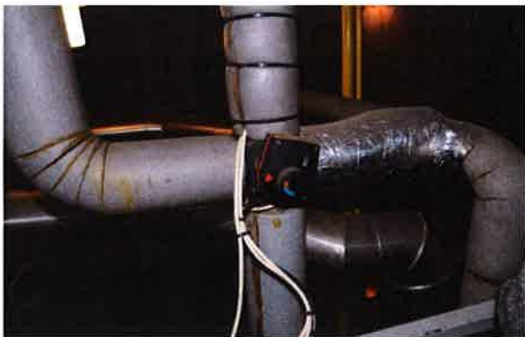
Plynová kotelna – centrální směšování
