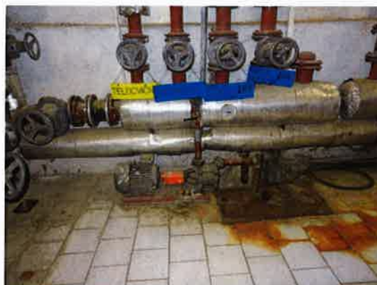
Plynová kotelna – rozdělovač
